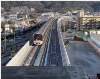
「船場トンネル」を出た北急箕面萱野行き
